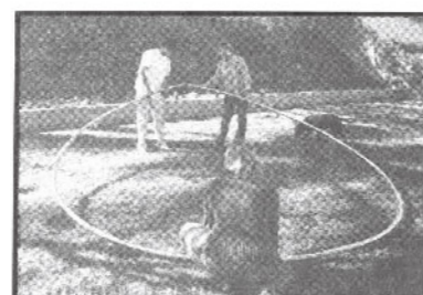
5 Продолжайте, пока Вы не получите большой круг. Для соединения последнего звена нужно трое взрослых здоровых людей в хорошей физической форме. При помощи третьего человека, держащего противоположные концы, соедините обе стороны круга вместе и зафиксируйте небольшими шурупами.
